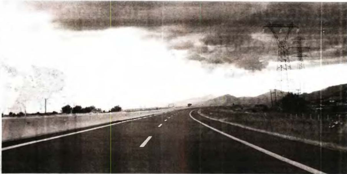
Σκοπός της μελέτης του ΑΠΘ είναι να διερευνήσει σε πιλοτικό επίπεδο τις αλλαγές που συμβαίνουν στις χρήσεις γης, στην εγκατάσταση επιχειρήσεων και στις αξίες γης στην άμεση ζώνη επιρροής της Εγνατίας οδού. ΦΩΤ. ΑΡΧΕΙΟΥ
