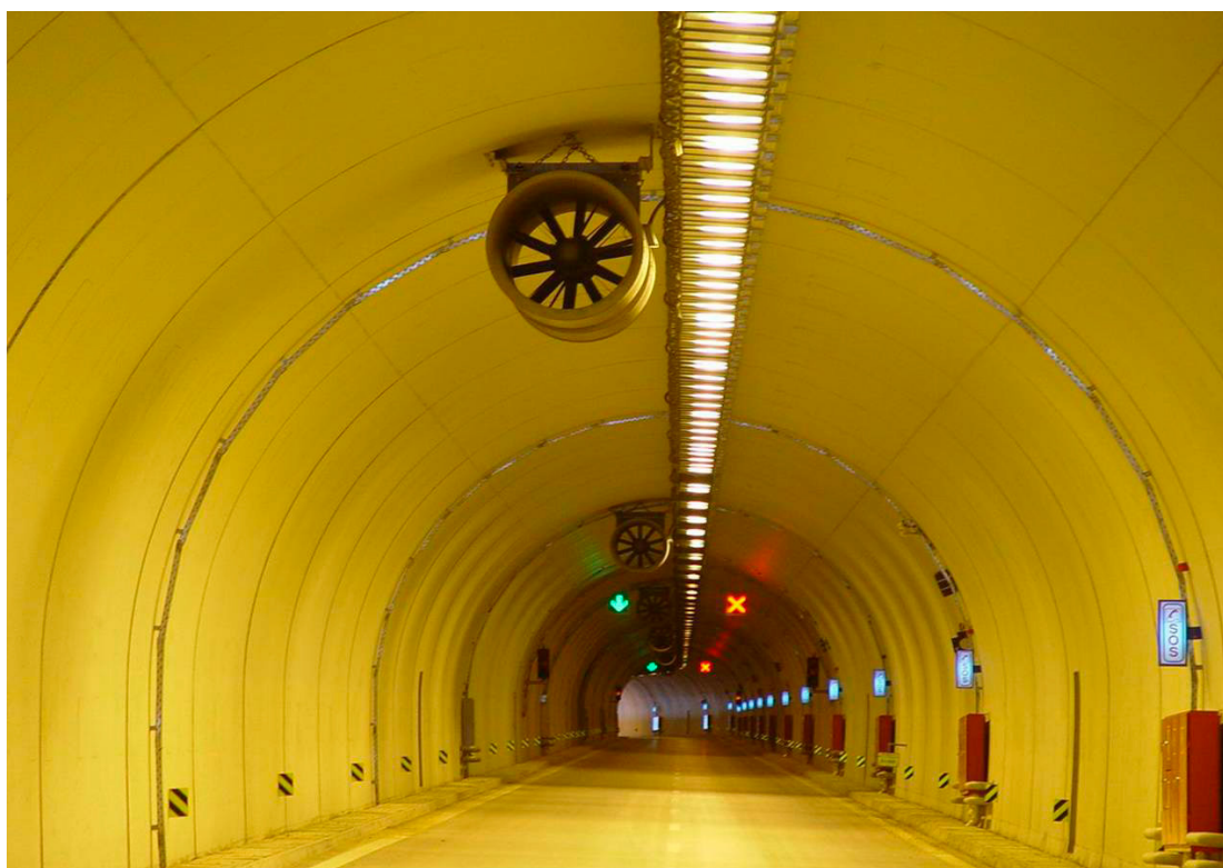
Φωτογραφία 7 Εσωτερική Διάταξη Σήραγγας στην Εγνατία Οδό.
