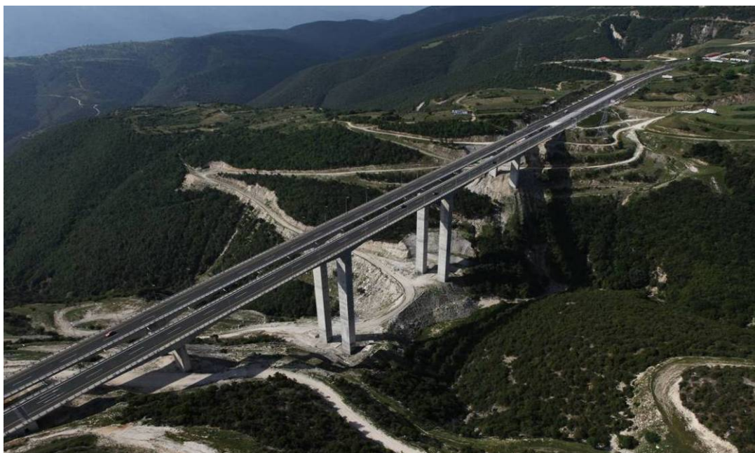
Φωτογραφία 8 Χαραδρογέφυρα Μετσόβου, Ιωάννινα.
