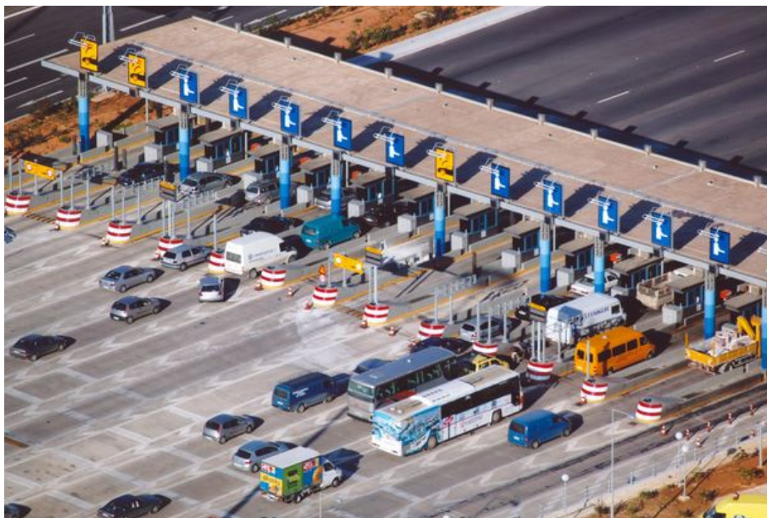
Φωτογραφία 2 Σταθμός Διοδίων Μαλγάρων, Θεσσαλονίκη.
