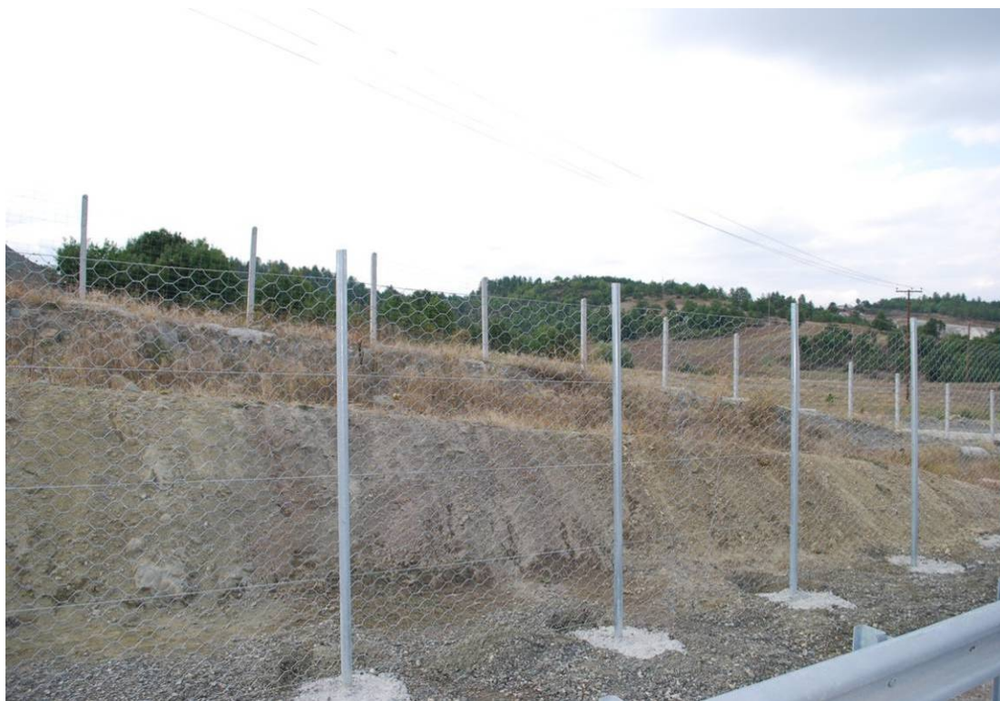
Φωτογραφία 3 Ενισχυμένη Περίφραξη κατά μήκος της Εγνατίας Οδού.
