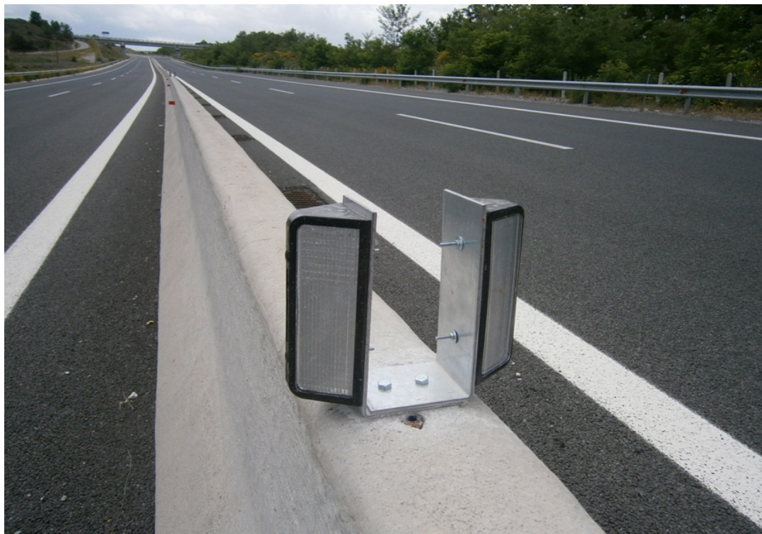
Φωτογραφία 4 Ανακλαστήρες (αποτρεπτικό μέσο εισόδου πανίδας στον αυτοκινητόδρομο).
